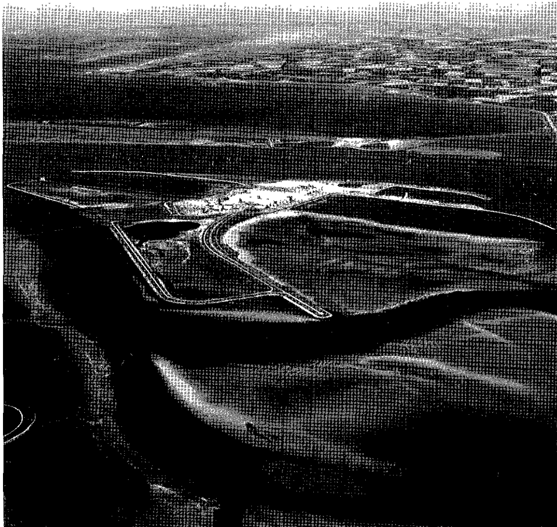
De Kreekraksluizen, met daarvoor de Plaat van de Vliet
